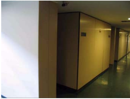
Figura 2 – Corredor com parede de concreto de 40cm de largura e paredes em divisória.
